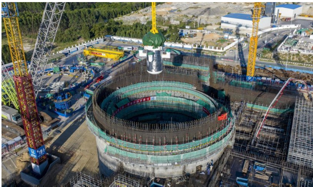
Le petit réacteur modulaire en construction à Changjiang en Chine, le 10 août 2023.
